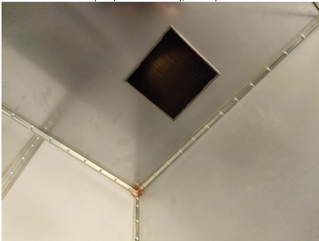
IMG_20211213_090524 Sposób łączenia listew narożnych wewnątrz komory rewerberacyjnej – prawy narożnik sufitowy, ściana tylna
