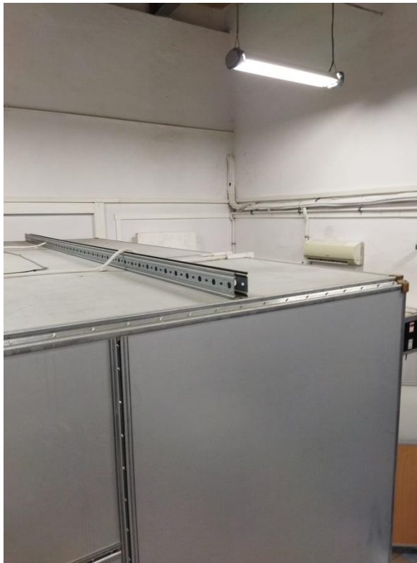
IMG_20211213_091241 Strop komory rewerberacyjnej – widok na ułożenie kabli w prowadnicach
