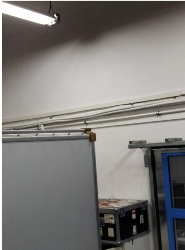
IMG_20211213_091337 Zewnętrzny narożnik komory rewerberacyjnej
